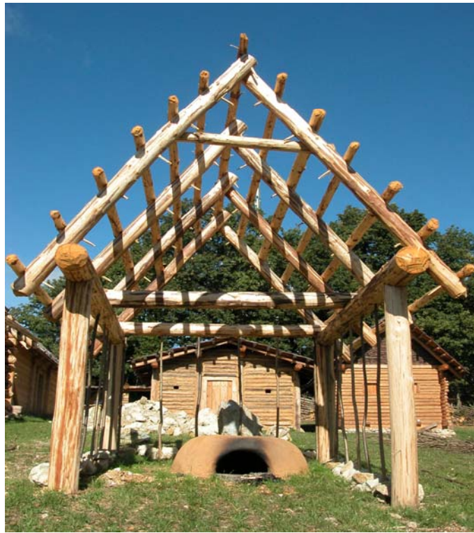
Abb. 28: Rohbau des Backhauses. Im Hintergrund ein Handwerkerhaus und das Speichergebäude.
