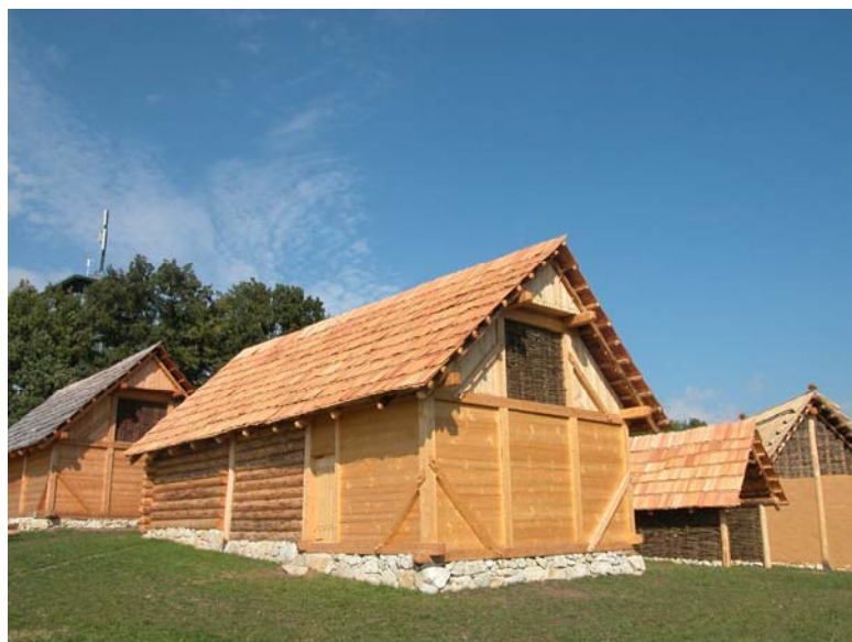
Abb. 2: Rekonstruktion späteisenzeitlicher Gebäude mit keltischem Werkzeug und Bautechniken beruhend auf den archäologischen Forschungsergebnissen..
